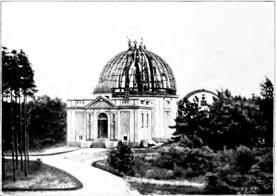
Kuppel für den großen Refraktor im Bau
